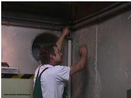
Hier testet der Mirko gerade die Möglichkeit, ein weiteres Kabel in das vorhandene Rohr einzuziehen. Immerhin hat er dadurch jetzt auch im Dieselmotorenraum die Gelegenheit am Beschallungsprogramm teilzunehmen ;-)))
