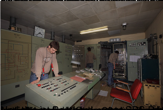
Die Aggregate sind über einen gemeinsamen Bus (500 V) mit dem Netz verbunden. Ein Dispatcher steuert die Aggregate über einen gemeinsamen Bus (500 V) mit dem Netz verbunden.
